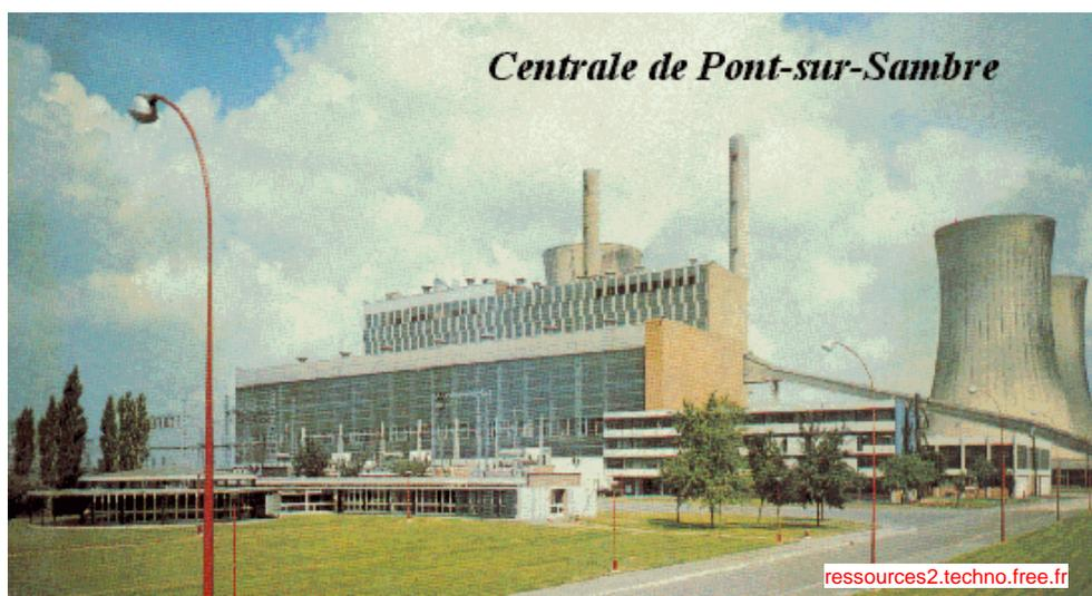
Les besoins en eau étaient assurés par la Sambre qui contournait la centrale. Le barrage du Val Joly sur l'Helpe Majeure (affluent de la Sambre en amont de la centrale) compensait le déficit d'eau entre le prélèvement et la restitution.
